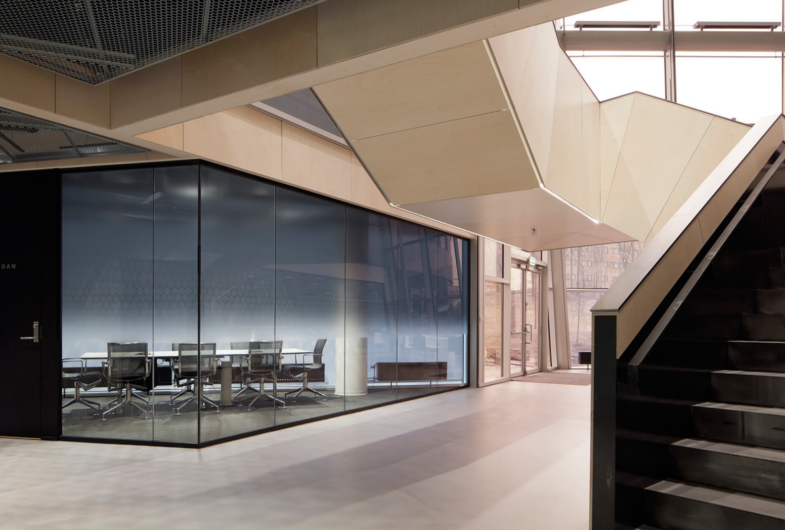
Systemvegg med topp og bunninnfesting (helglass vegg). Foto: Moelven
